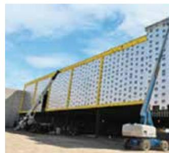
Le polyisocyanurate est un isolant utilisé dans plus de 70% des marchés commerciaux et résidentiels pour les applications de murs et de toits aux États-Unis.
